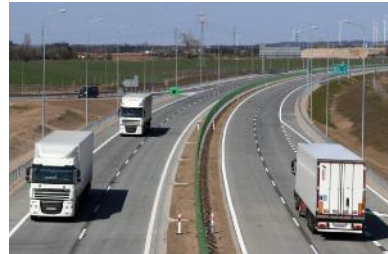
S61 Obwodnica Suwałk
