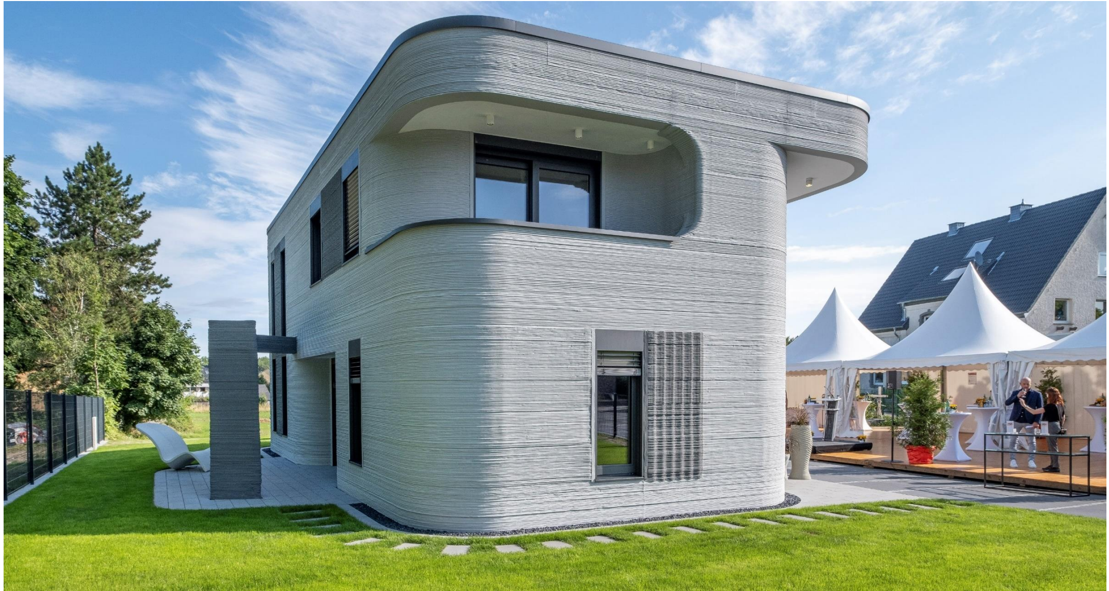
Budynek wykonany w technologii druku 3D , Beckum, Niemcy
